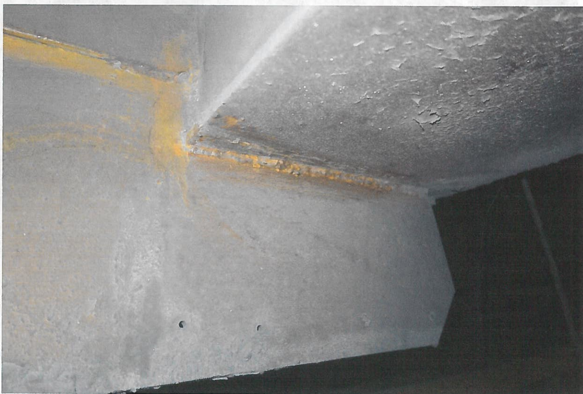
Fot. 3.4. Spoiny mocowania dźwigara głównego mostu do czołownicy- pas dolny, strona lewa.
