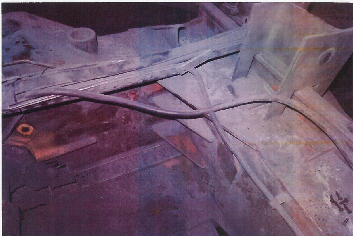
Fot. 3.1. Połączenie dźwigara głównego mostu z czołownicą – strona lewa.
